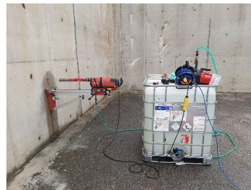
Odvrtání vrtného jádra konstrukčního betonu ÚRAO pro stanovení vstupních parametrů modelů
